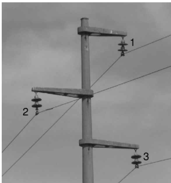
СЛИКА 2 – ГЛАВА СТУБА БР. 1876 СА ОЗНАКАМА ФАЗНИХ ПРОВОДНИКА
